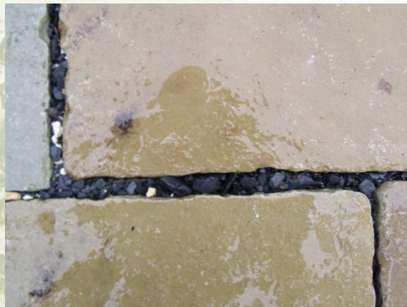
Détail des joints d'ardoises pillées
