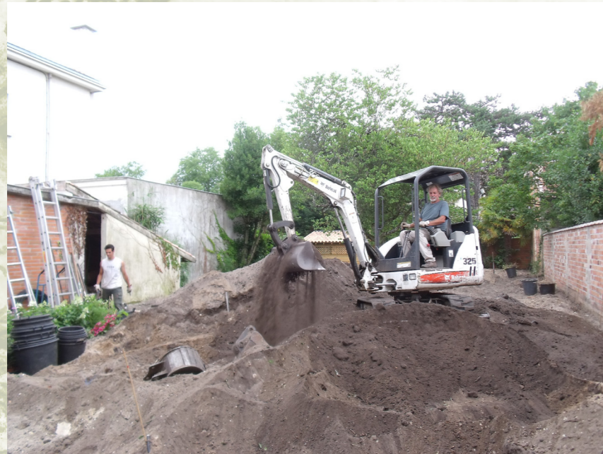
Travaux de terrassement
