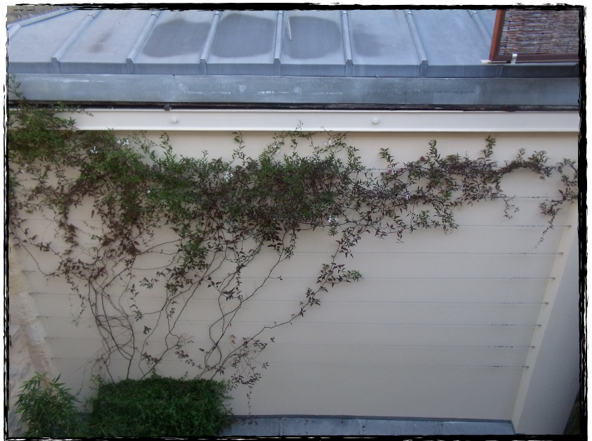
Mur Végétalisé après une année de végétation
