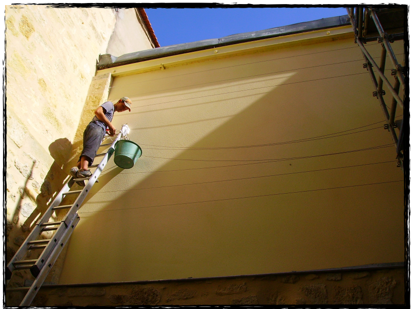
Mise en place des câbles en inox de 4mm
